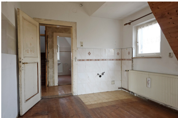
Raum mit Küchenanschluss OG
